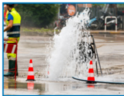
Not-Desinfektion bei Wasserversorgung aus Hydranten
